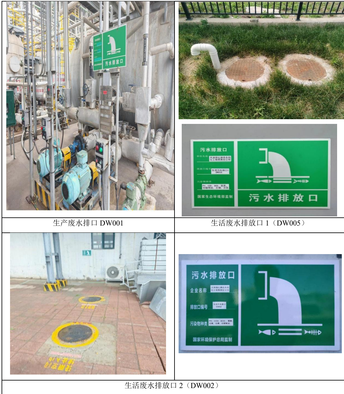
图 2-8 厂区废水排污口规范化设置
