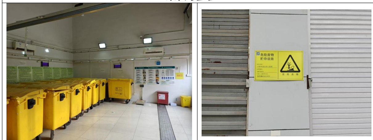
医疗废物暂存间
