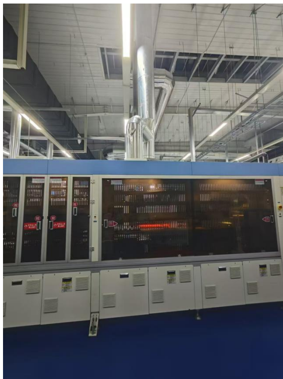
划焊一体机收集管道
