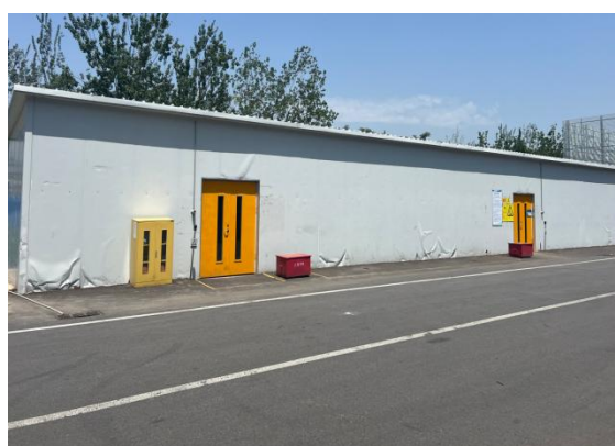
危险废物暂存间
