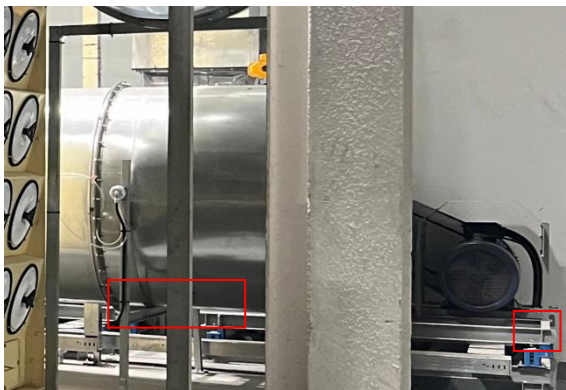
风机减振装置
