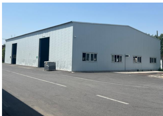
一般固体废物暂存间
