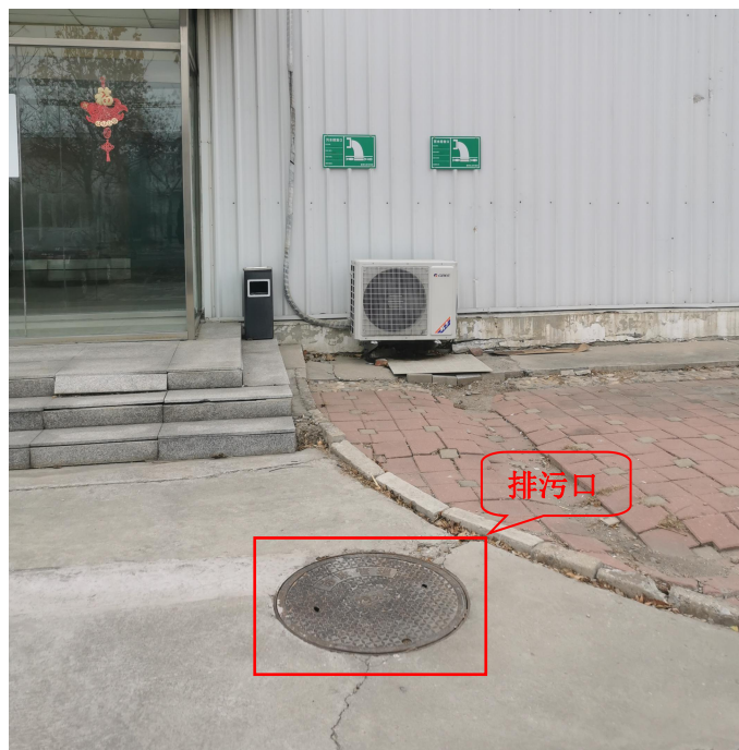
图 3-3 厂区废水排口
